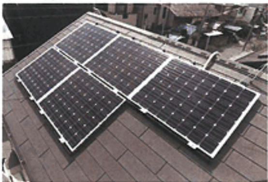
同社が施工した住宅
